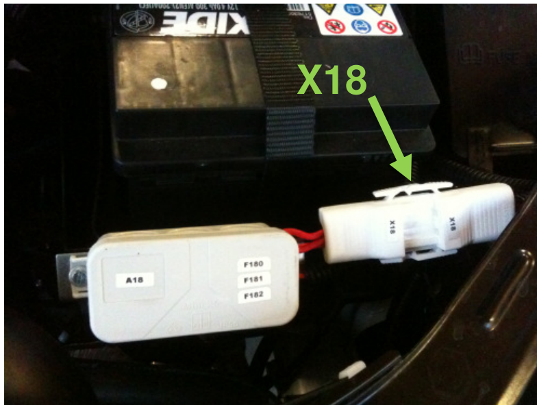
Stecker X18 vor der Bordbatterie im Motorraum.
